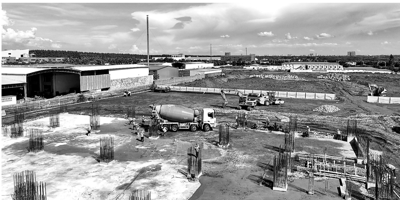
6月29日,广东徐闻经济开发区园区基础设施建设现场一派繁忙景象。本报记者 张锋锋 实习生 陈春霖 摄
