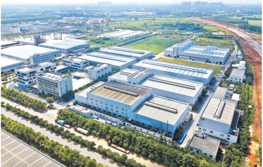
湛江大型产业集聚区奋勇片区，广东东岛新能源厂房一角。 本报记者 刘冀城 摄
