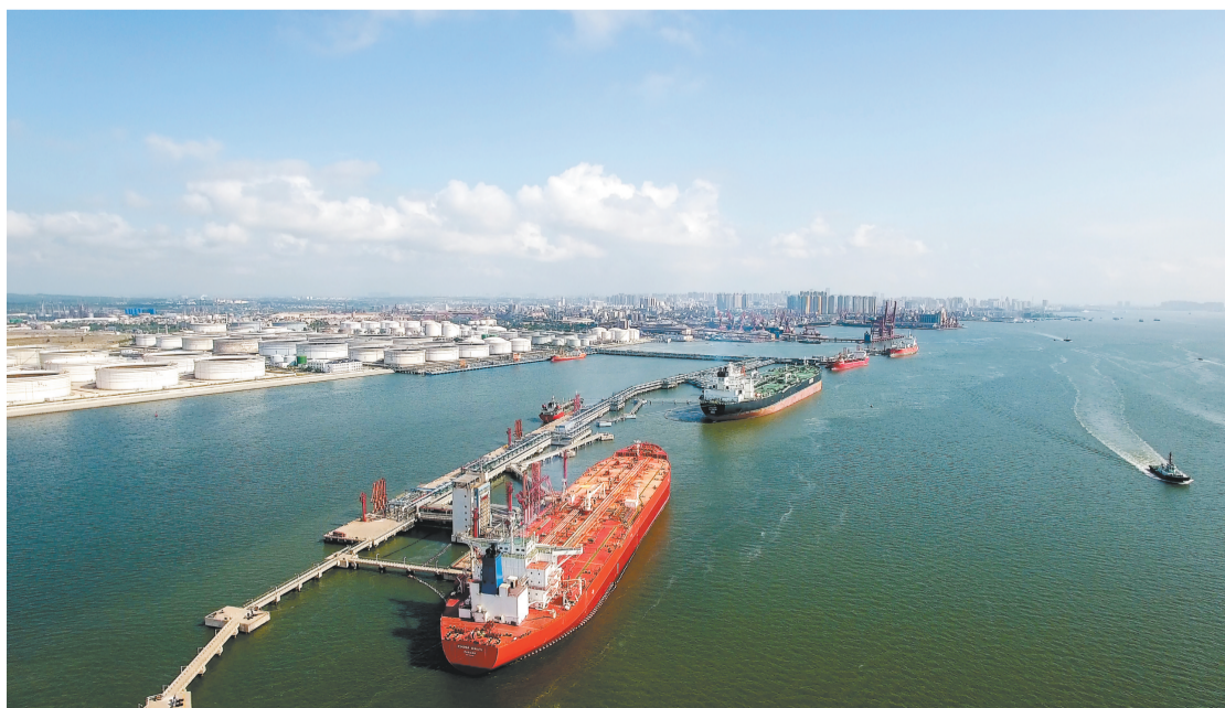
万吨巨轮靠泊湛江港油码头装卸。
