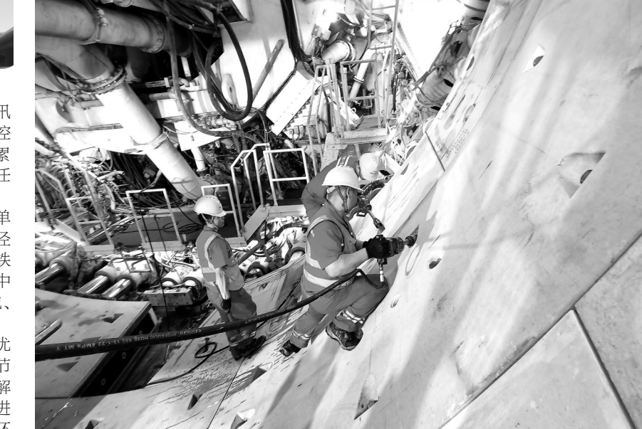
12月29日上午,施工人员在拼装管片。 本报记者刘冀城 通讯员张鹏飞 摄
