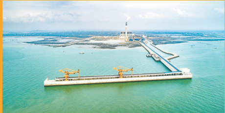
位于雷州经开区C区的大唐电厂。 本报记者 张锋锋 摄
