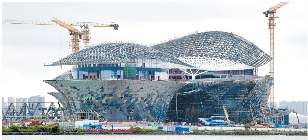
6月4日,由中建深装承建的湛江文化中心幕墙安装施工正在紧张进行。该建筑62500平方米幕墙由超过一万块不同尺寸的新变幻彩铝板和玻璃组成,目前已完成安装90%。建成后的湛江文化中心三面环海,包括大小剧院、美术馆、博物馆等功能区域,将成为湛江文化新地标。本报记者郎树臣 摄影报道
