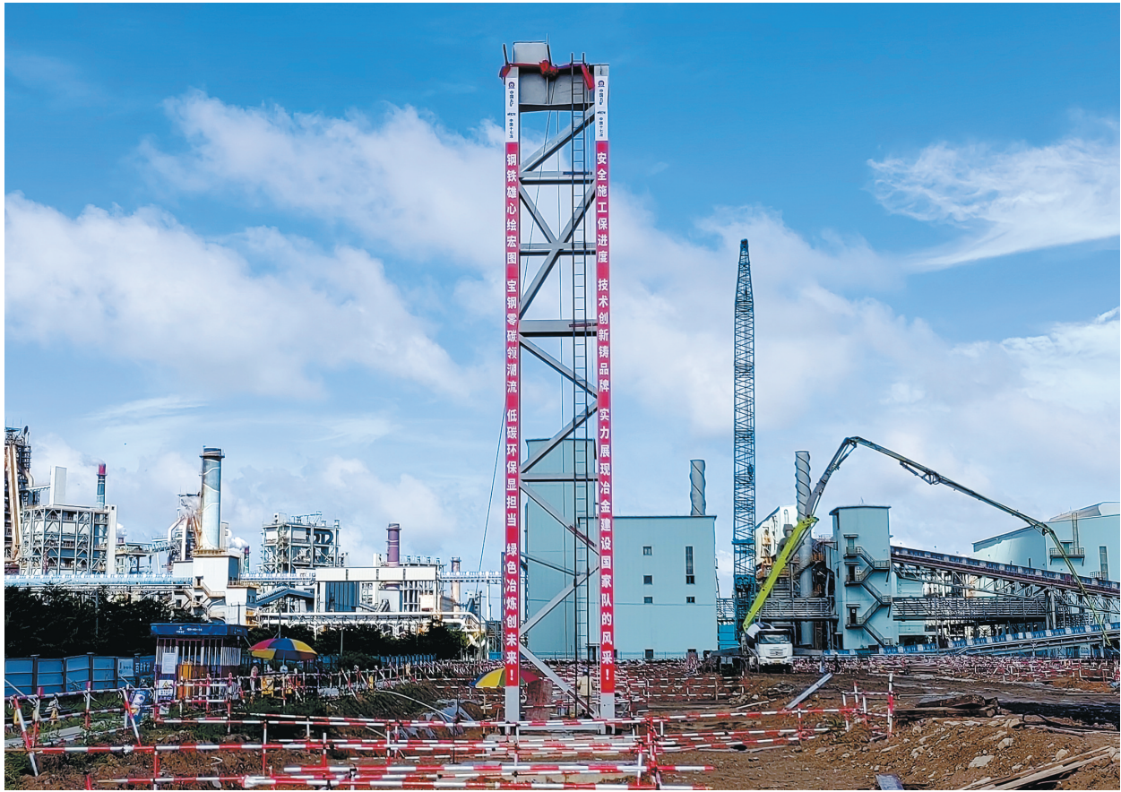
宝钢湛江钢铁零碳高等级薄钢板工厂项目钢结构首吊成功。(湛江钢铁 供图)
