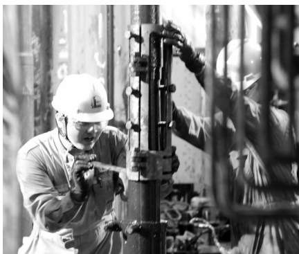
工程师正在检查取心工具。 通讯员 莫万洁 摄
