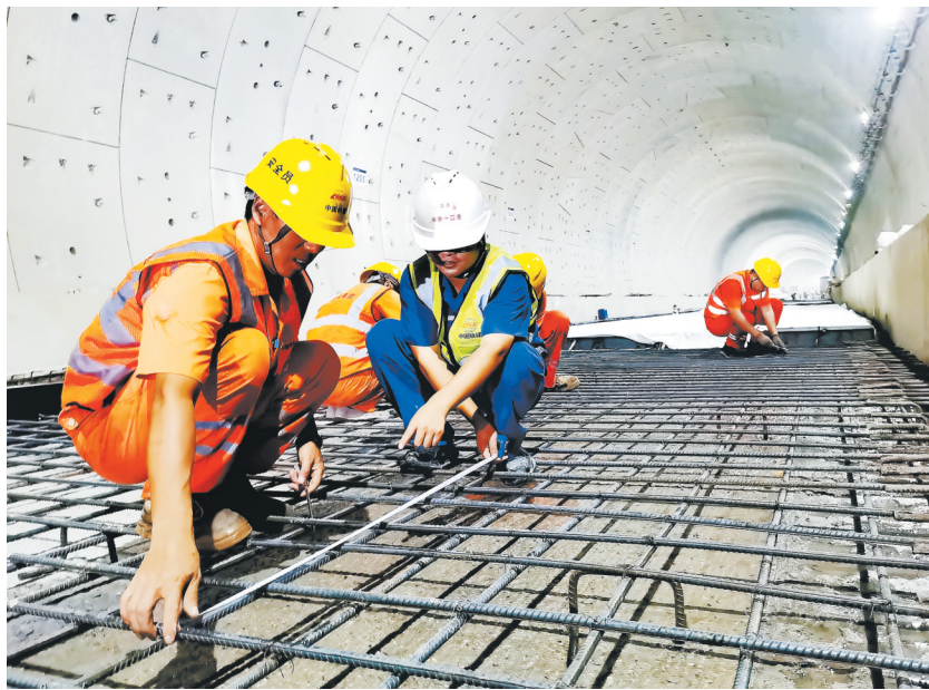
10月16日,广湛高铁湛江湾海底隧道项目施工现场。记者刘冀城 通讯员王略 摄
