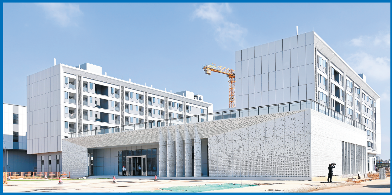
湛江市奋勇高新区承接产业转移主平台基础设施建设项目(一期)标准厂房、公共服务中心、仓库等相继拔地而起。 本报记者张锋锋 摄
