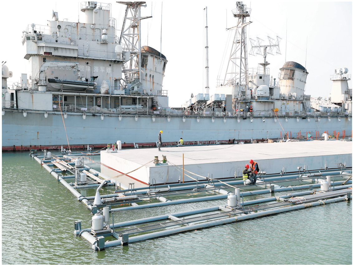
工作人员在加紧施工。
