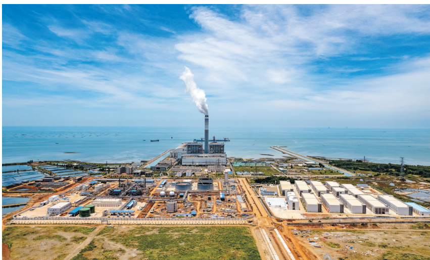
航拍位于雷州乌石临港工业园区的乌石23-5油田群陆地处理厂区(画面后面的是大唐发电厂)。
