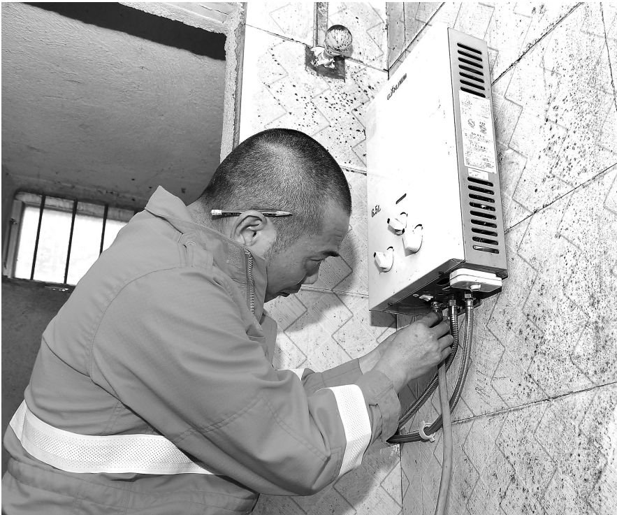
工作人员为居民迁移安装燃气热水器。 本报记者殷翊展 摄
