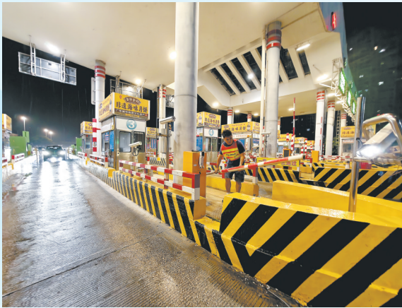
湛江海湾大桥收费站工作人员进行拆杆。
