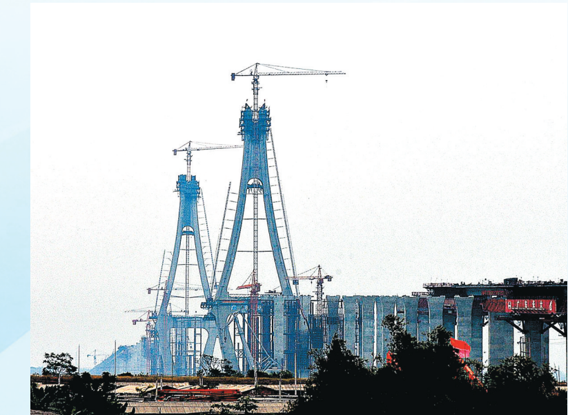
2005年12月8日,湛江海湾大桥主塔封顶。 林雨松 摄
