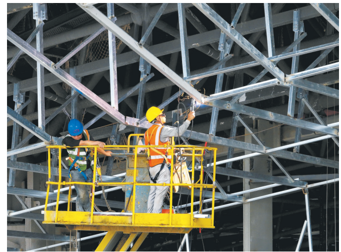
工作人员在加紧施工。
