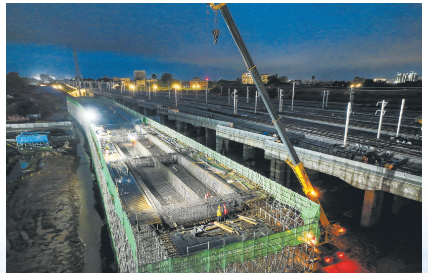
6月30日晚，湛江北站周边的配套工程也在加紧施工。
