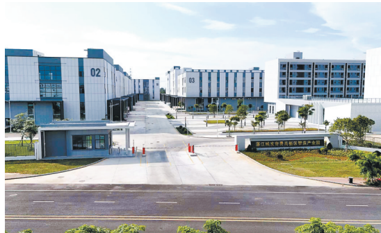
湛江市奋勇高新区承接产业转移主平台基础设施建设项目(一期)。 受访者供图
