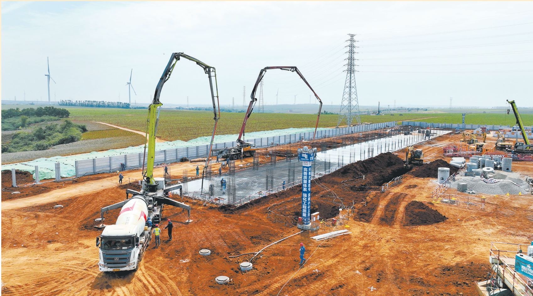
500千伏徐闻东输变电项目正在建设中。 通讯员詹旬 摄
