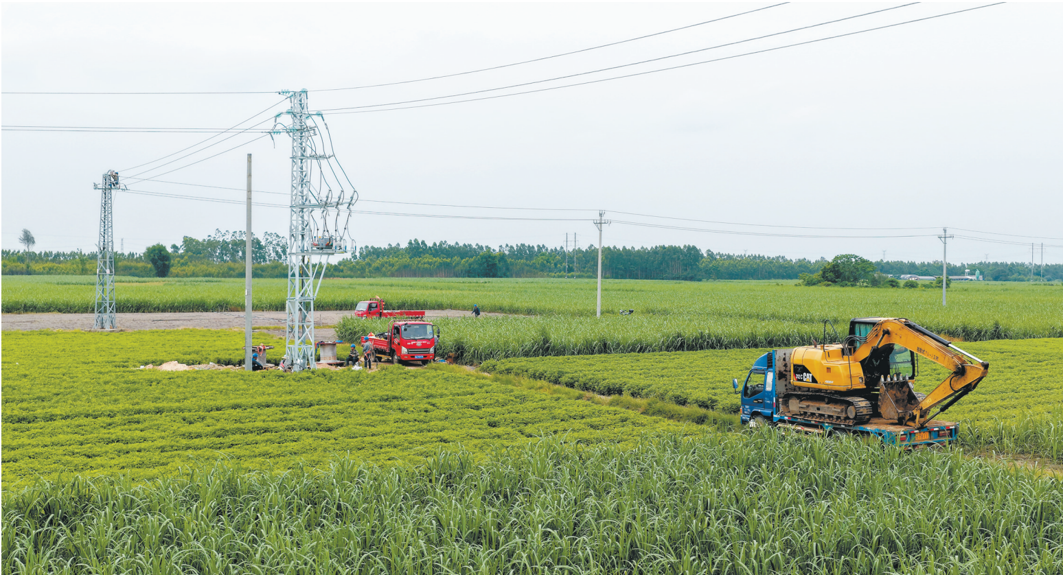
110千伏整线成片绝缘化改造施工现场。 通讯员陈娴 摄
