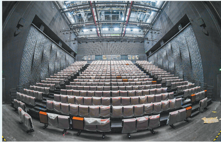
多功能剧场的可移动座椅安装完毕。
