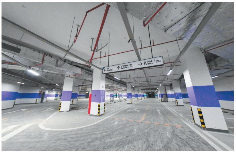
可同时停放500多辆车的地下停车场。
