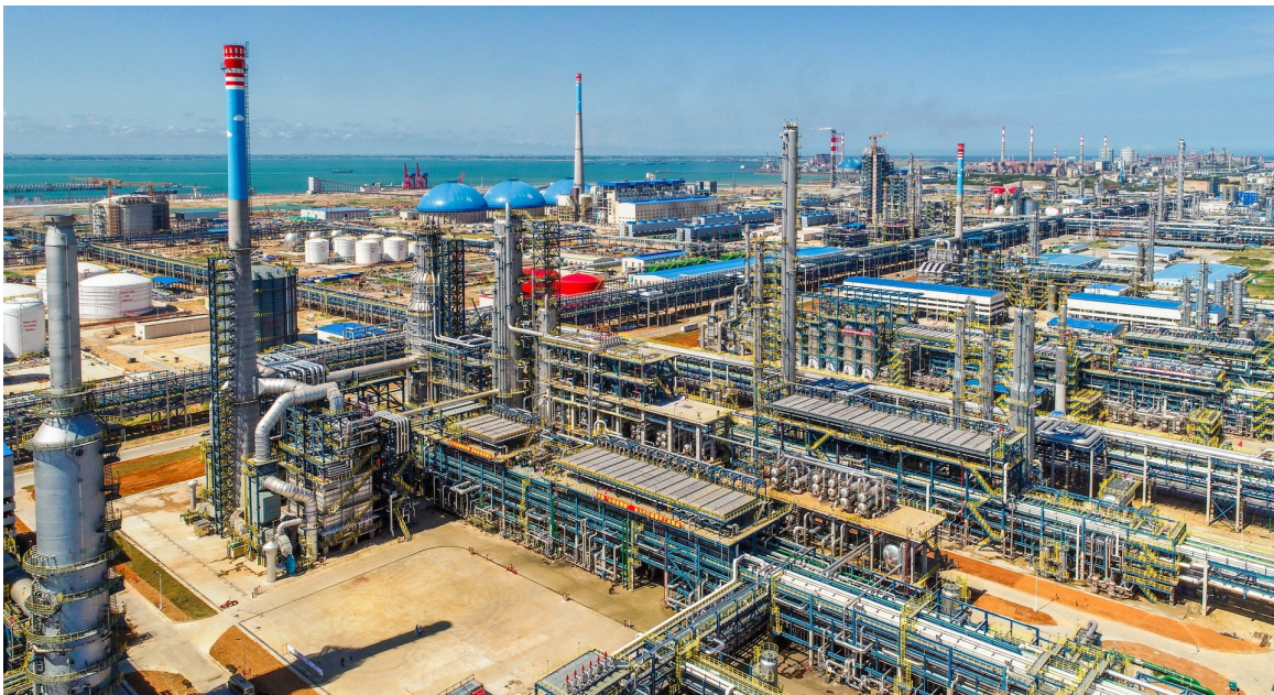
中科炼化一体化项目基地。 记者 张锋锋 摄
