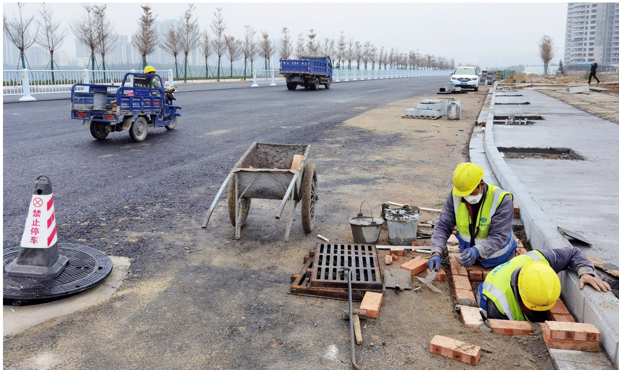
赤坎区欢乐大道，工人在做下水道的排水口。 记者 李波 摄
