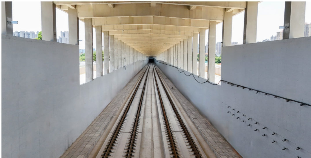
铺设完成的双线轨道。 通讯员 王略 摄
