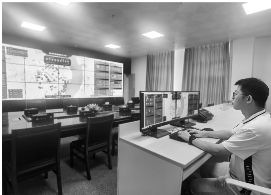
工作人员在操作智慧停车系统。受访单位供图
