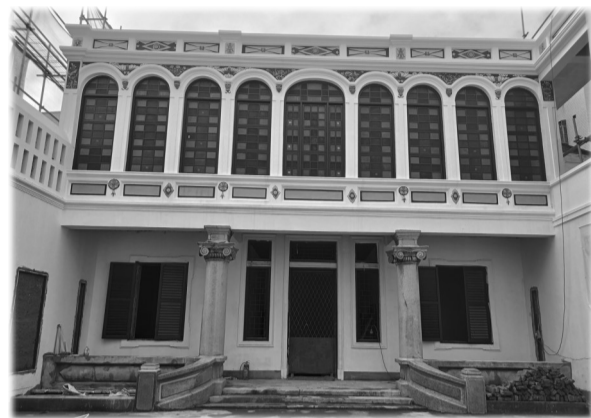
修旧如旧的静园小楼。
