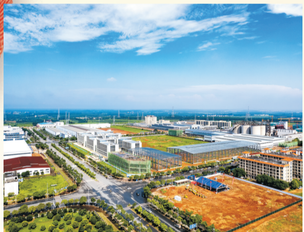
雷州广湛园(奋勇高新区)2024年二季度项目集中开工活动现场。 本报记者李忠 摄
