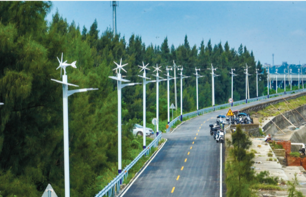
升级改造后的沿海道路。 本报记者 张锋锋 摄
