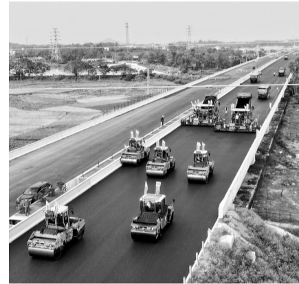
施工现场。 本报记者郎树臣 通讯员李俊禧 摄
