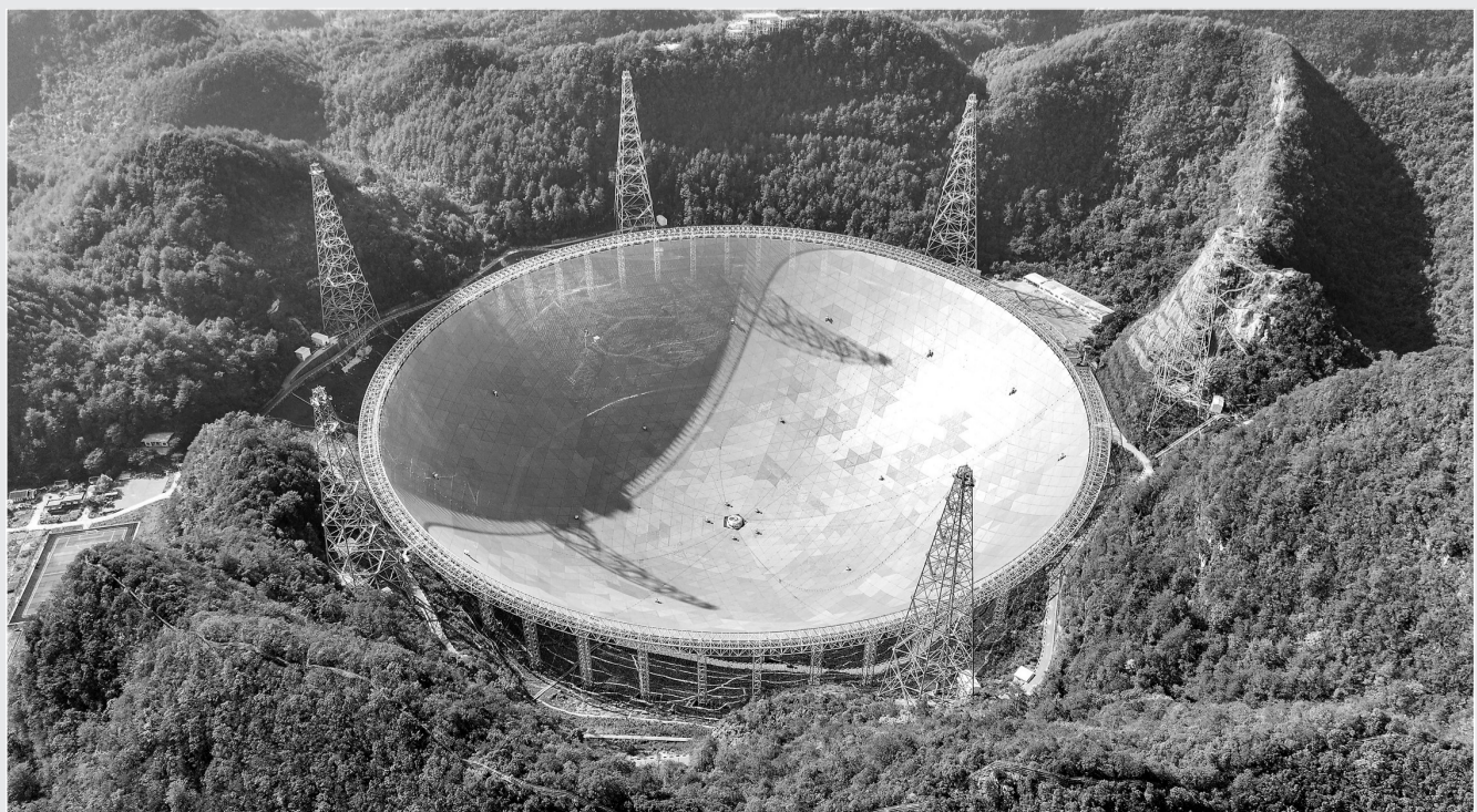
这是9月25日拍摄的“中国天眼”全景(无人机照片,维护保养期间拍摄)。新华社记者 欧东衢 摄
