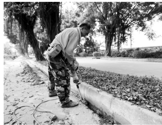
工人在百蓬路打线槽维修路灯。本报记者李忠 摄
