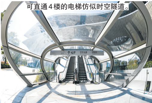
可直通4楼的电梯仿似时空隧道。
