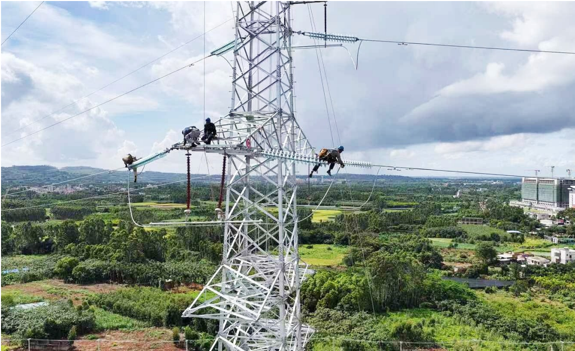
施工现场。 湛江供电局供图
