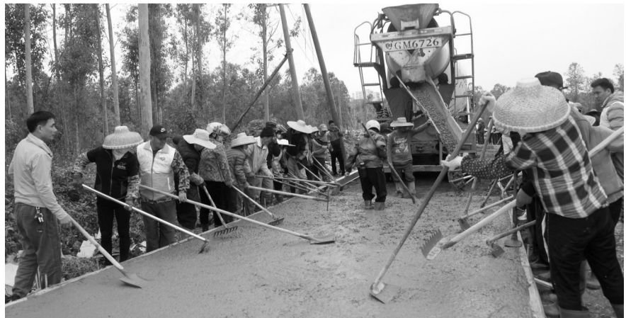
图为修路现场。 通讯员供图
