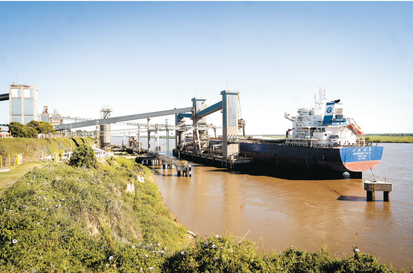
这是12月13日在阿根廷圣菲省廷埃斯港拍摄的装载小麦的货轮。一艘装载6.5万吨阿根廷小麦的货轮13日从该国圣菲省廷埃斯港启航前往中国。这是阿根廷2024年1月获得对华小麦出口资质后首次向中国开展小麦商业出口。
