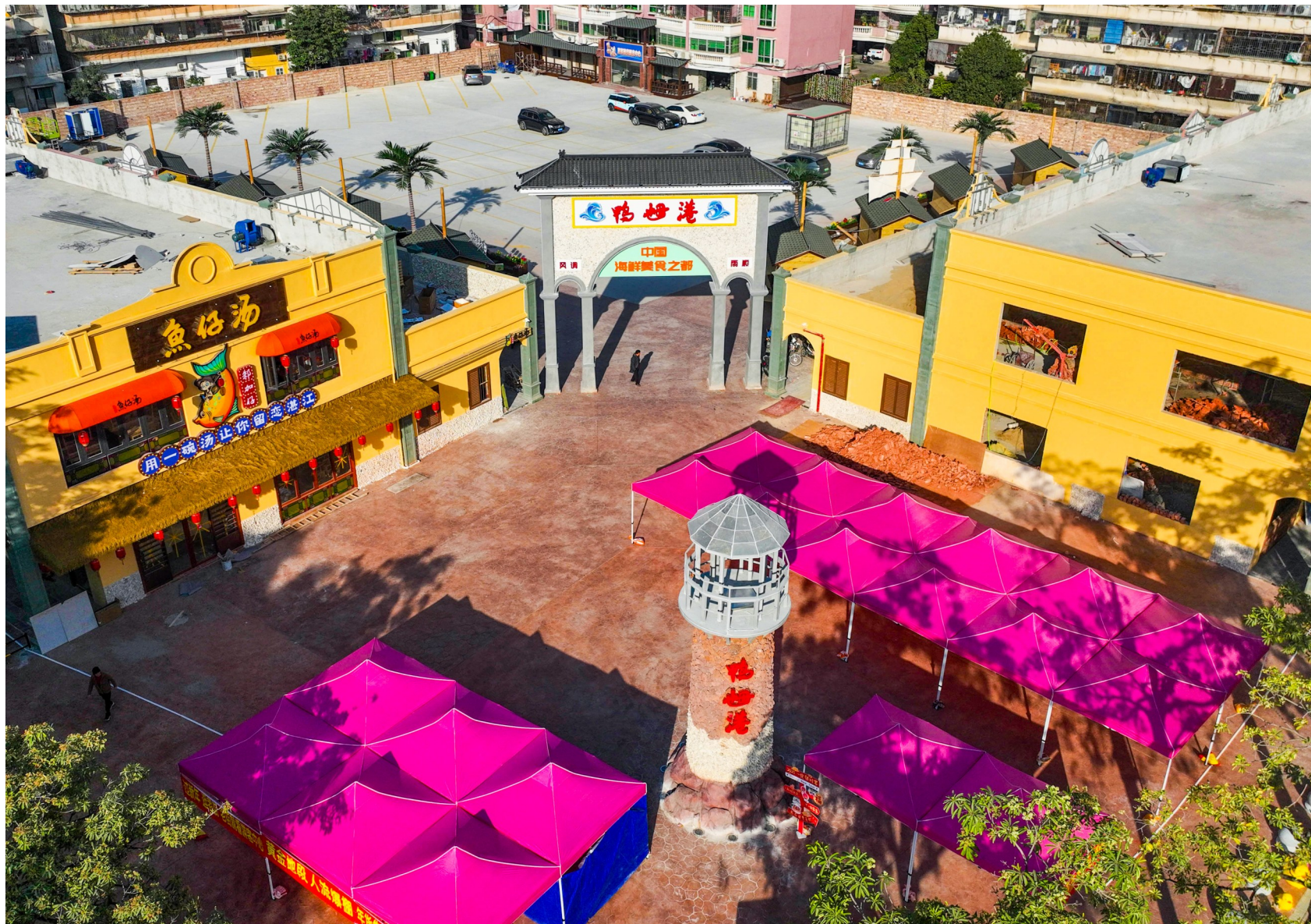
“鸭嘴港码头”游客接待中心外部装饰已经基本完成。 记者 郎树臣 摄
